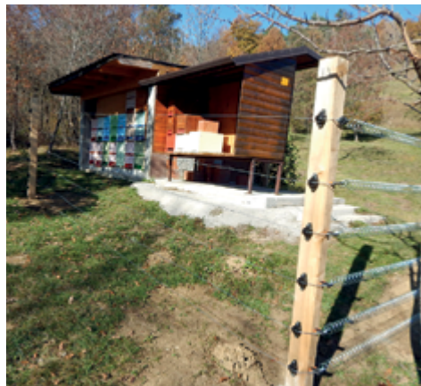
Pčelinjak zaštićen šesterožičanom ogradom. (Foto: Tomaž Berce)
