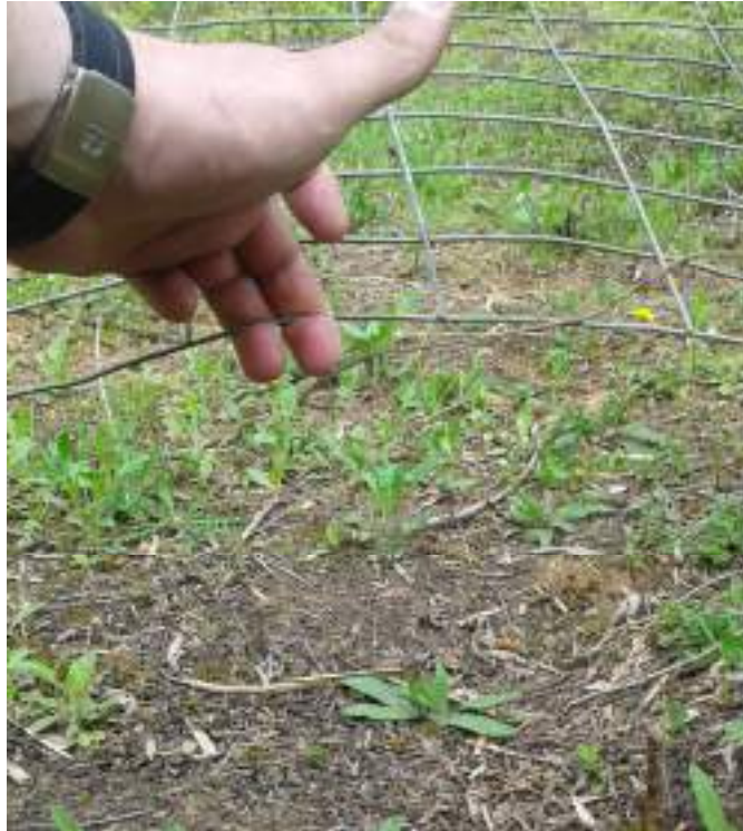
Slika 27: Neadekvatno učvršćen donji dio ograde koji omogućava ulazak životinja
