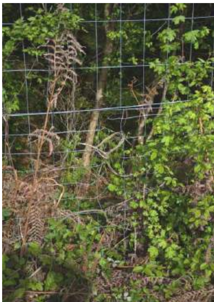
Slika 18: Jedno od vertikalnih oštećenja ograde koje je vjerojatno nastalo prilikom malčiranja vegetacije
