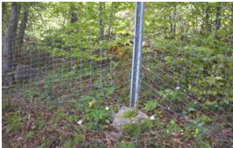
Slika 37: Na problematičnom području česti su slučajevi lošeg učvršćenja ograde
