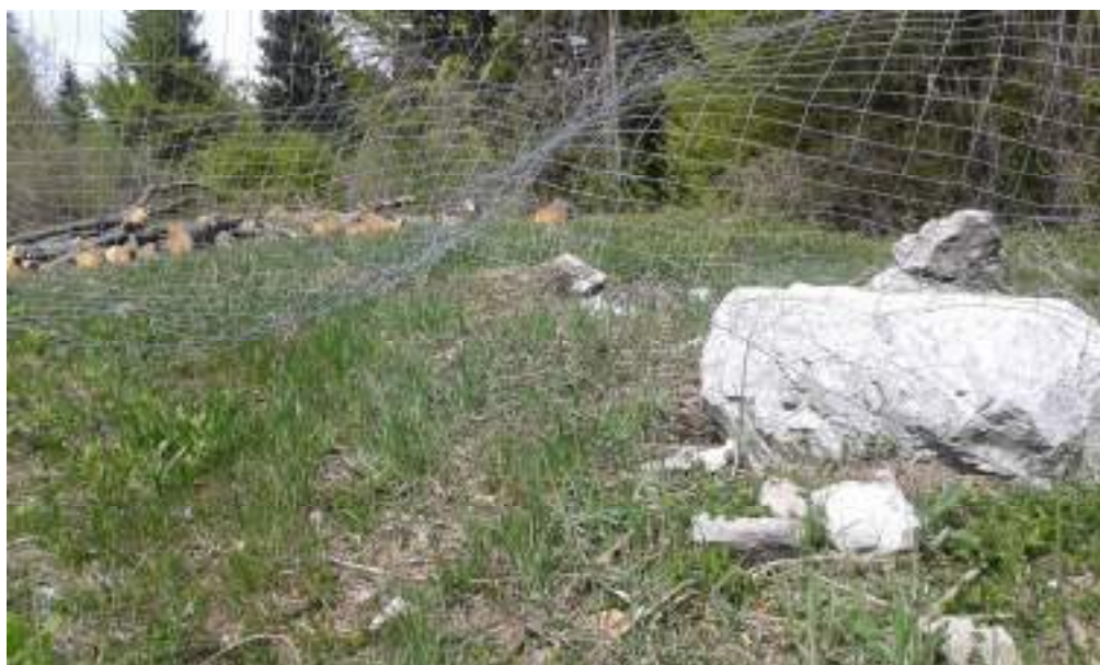
Slika 38: Neadekvatno postavljena ograda
