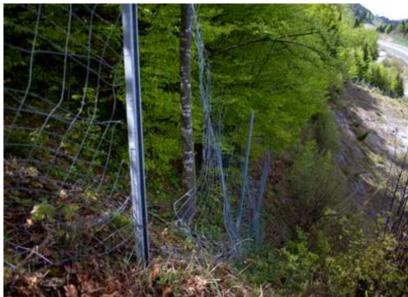
Slika 36: Veliki otvor u ogradi koji omogućava ulazak životinja na autocestu
