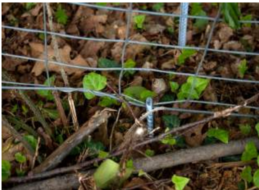
Slika 31: Učvršćenje donjeg dijela ograde pomoću klina
