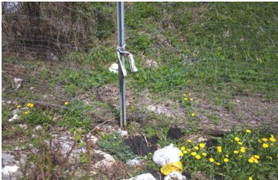
Slika 34: Potrgana ograda i smeće na ugibalištu autoceste neposredno iza spremnika za smeće „otpornog“ na medvjede
