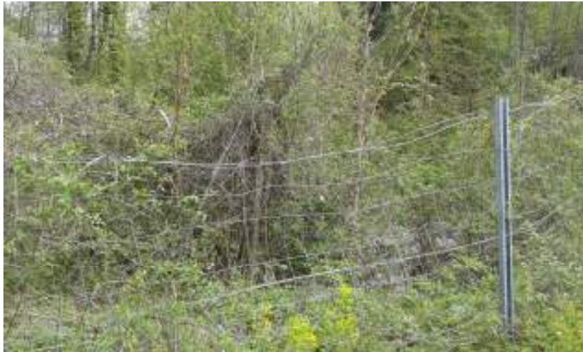
Slika 45: Povinuti gornji dio ograde, najvjerojatnije uslijed preskakanje ograde od strane divljih životinja
