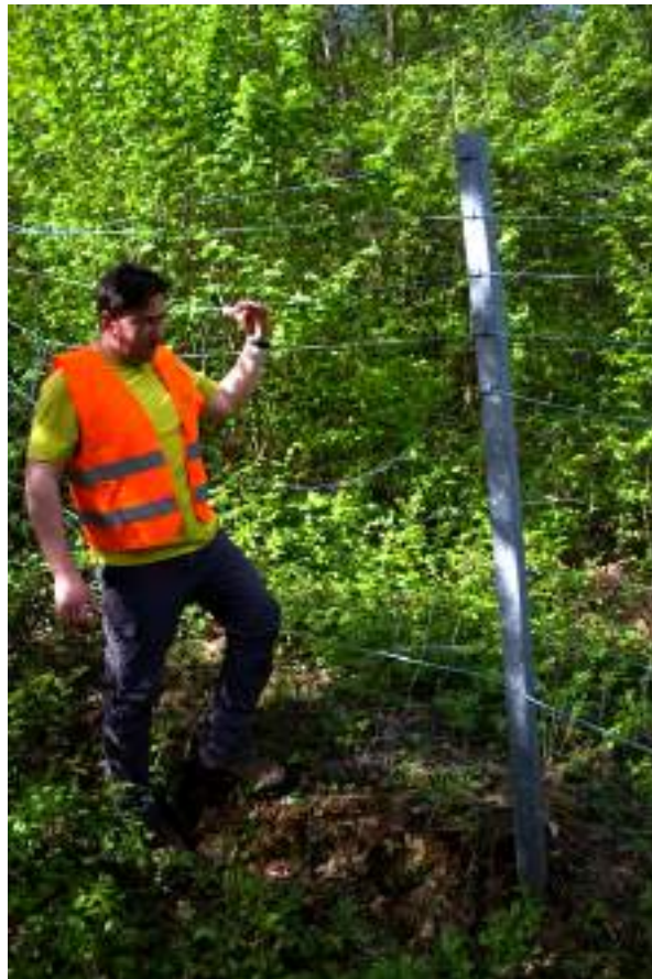
Slika 25: Ograda spuštena do visine od 1 metra omogućuje lagan ulazak srna na prostor autoceste
