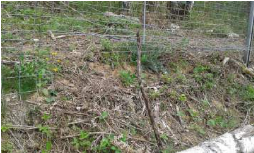
Slika 28: Nestručno dorađen donji dio ograde koji omogućava ulazak životinja, ali ne i izlazak iz ograđenog prostora
