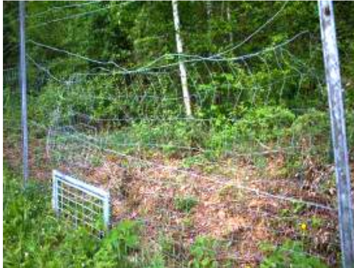
Slika 24: Nefunkcionalna izlazna vrata za male životinje, loše stanje okolne žice i otvor u žici
