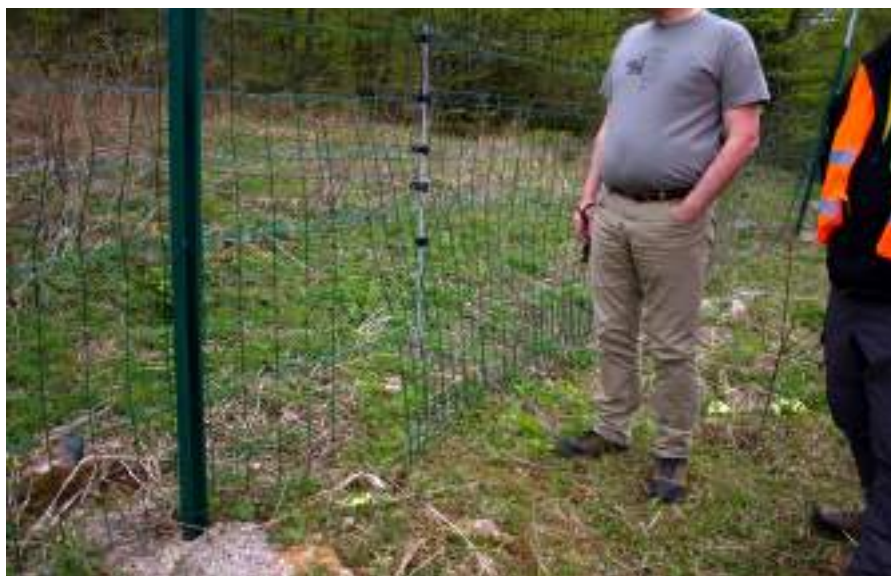
Slika 41: Otvor u ogradi kod zelenog mosta Dedin
