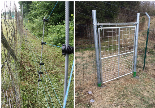
Električna ograda duž autoceste Rijeka - Zagreb. Velika jednosmjerna izlazna vrata na autocesti Rijeka - Zagreb.
