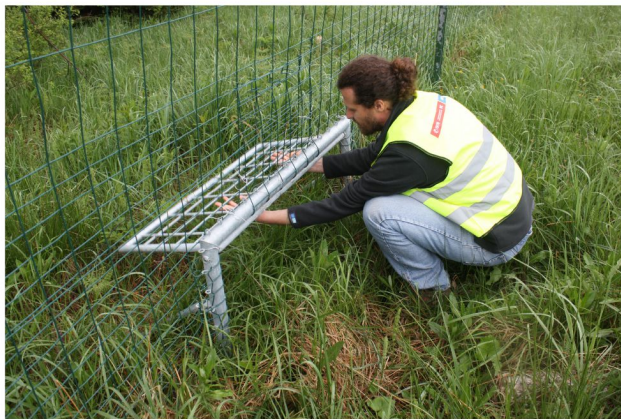
Jednosmjerna izlazna vrata za životinje iz ograđenog prostora autoceste. Manja varijanta vrata.
