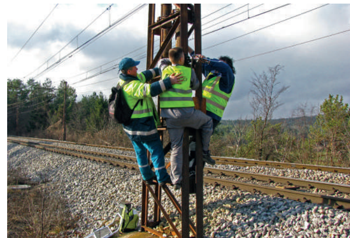
Nameščanje zvočnih odvrčal ob železniški progi.
