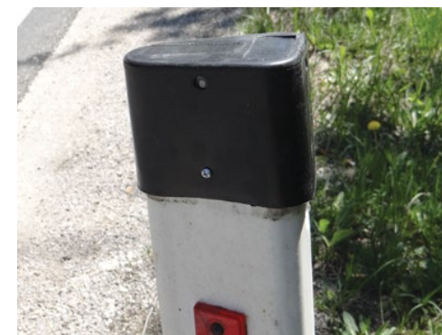
Zvočna odvrtača smo namestili na cestne stebričke na problematičnih cestnih odsekih.
