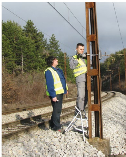
Zvočna odvrtača, ki so nameščena na električne drogove ob železniški progi.
