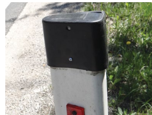
Dissuasori acustici con sensori sono stati installati nei paracarri stradali lungo la carreggiata nella maggior parte dei tratti stradali critici.
