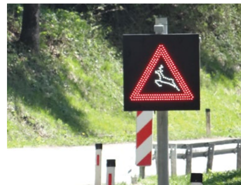
Segnali stradali dinamici che allertano i conducenti sulla presenza di fauna selvatica in prossimità della strada.
