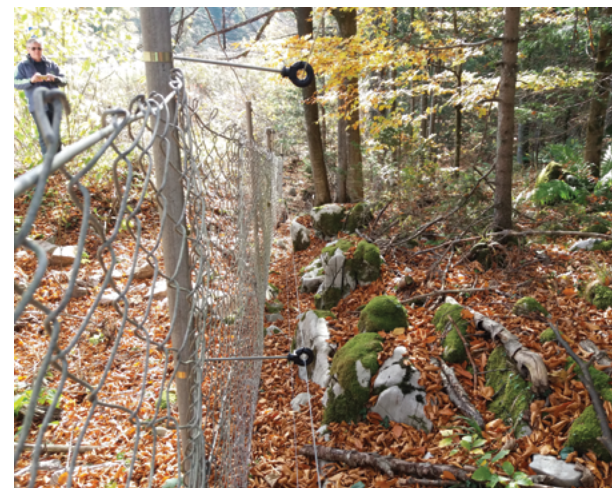
Električna ograda postavljena na Primorskoj autocesti na dionici između Logateca i Loma u svrhu smanjenje stradavanja medvjeda i ostalih divljih životinja u prometu.
