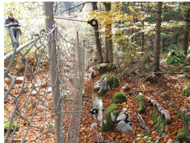
Am Autobahnzaun installierte Elektrolitzen bei Logatec sollen Bärenunfälle reduzieren.
