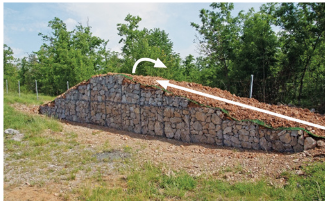
Una delle rampe "salta fuori" per l'uscita della fauna selvatica dal corridoio autostradale. Gli animali possono salire sulla rampa e poi saltare sopra il recinto.
