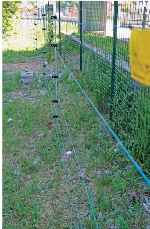
Recinzione elettrica sull'autostrada Fiume-Zagabria.
