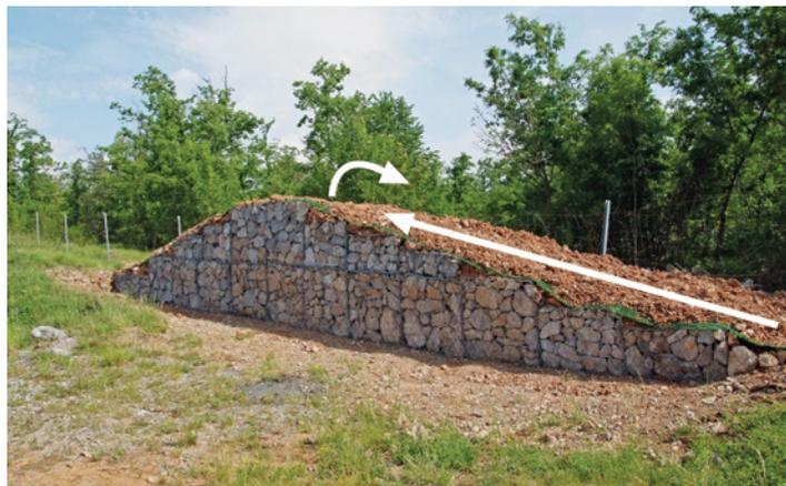
*Eine Ausprungrampe für Wildtiere, die es ihnen ermöglicht die Autobahn zu verlassen. Die Tiere können die Rampe hochlaufen und anschließend über den Zaun springen.*
